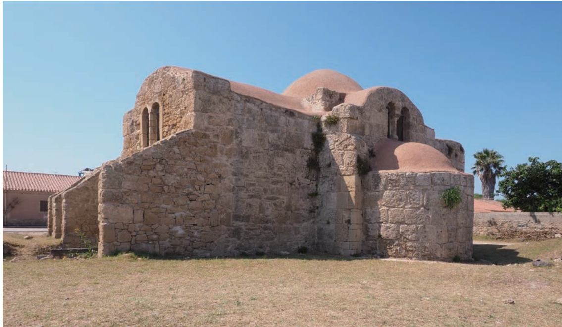
[12] L'abside della chiesa di San Giovanni di Sinis. L'impilamento delle pietre differisce a seconda dell'epoca in cui l'edificio venne ampliato.
