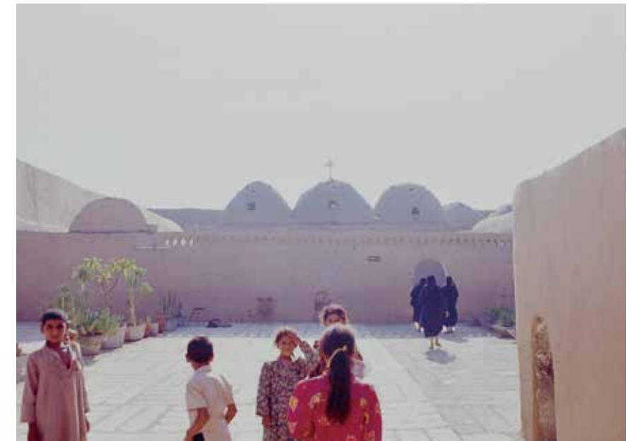
[13] シュハーダ修道院 (Deir al Shuhada) ナイル川中域のアミーンにあるコプト修道院。創建は古代に遡るが、現在見られる聖堂はファティマ朝(9~11世紀)頃に成立したと考えられ、3×3ベイを基本に増築されている。構造は日干し煉瓦と焼成煉瓦による組積造。砂漠にあるので砂に埋もれないよう、そして外敵の侵入を防ぐために、施設全体が壁で囲まれている。 Monastero di Dayr Al-Shuhada, XIII secolo circa, Esna, Egitto.
